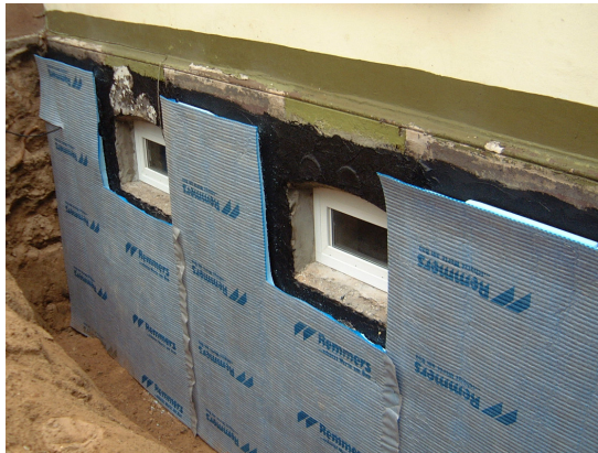
Polyethylen-Noppenbahn der Fa. Remmers mit Filtervlies und Gleitfolie
