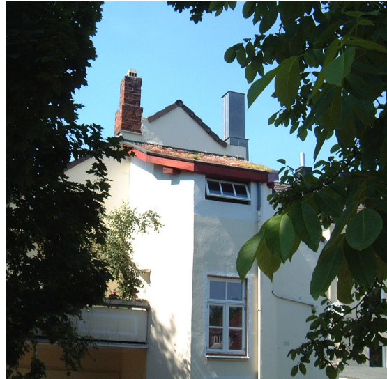
Das Gebäude nach der Sanierung mit erhöhtem Treppenturm und einem extensiv begrüntem Dach und neuen fenstern
