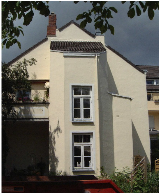
Das Gebäude vor der Sanierung mit dem vorgesetztem Treppenturm und den alten Fenstern
