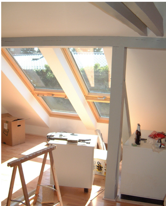
Einbau sog. Cabrio-Fenster
