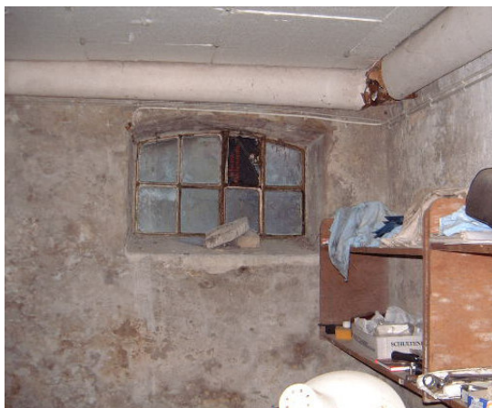
Kelleraußenwände vor der Sanierung
