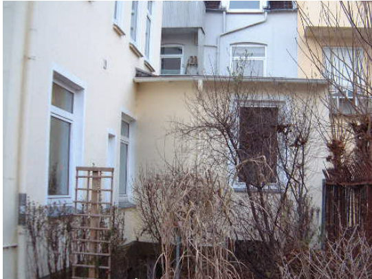
Anbau vor der Sanierung
