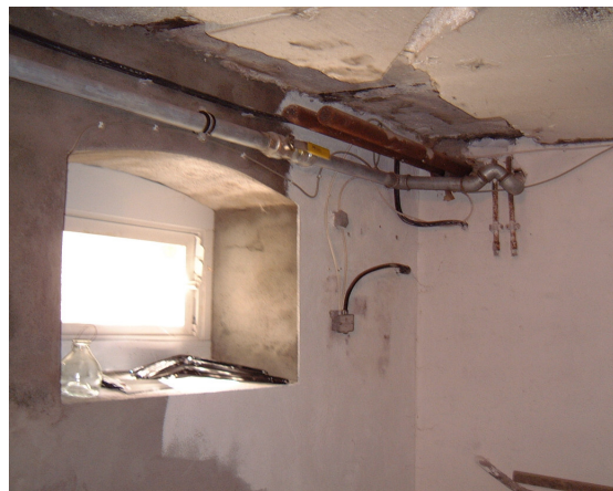
Innensanierung aller Kelleraußenwände mit Verkieselung, Sulfatexschlämme und Sanierputz nach Vorgabe der Fa. Remmers
