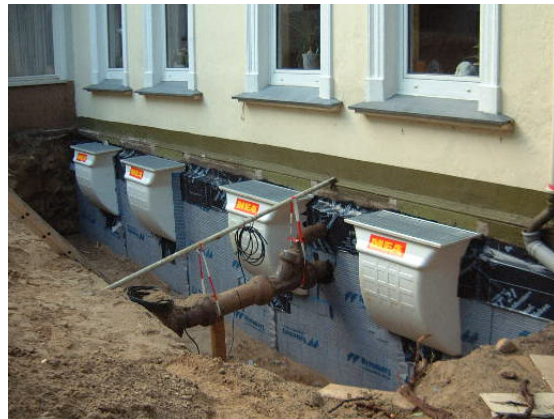
Anbringen der neuen Kellerlichtschächte
