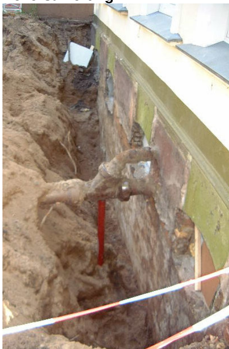
Abgrabung bis zum Sockelpunkt -3,2 m
