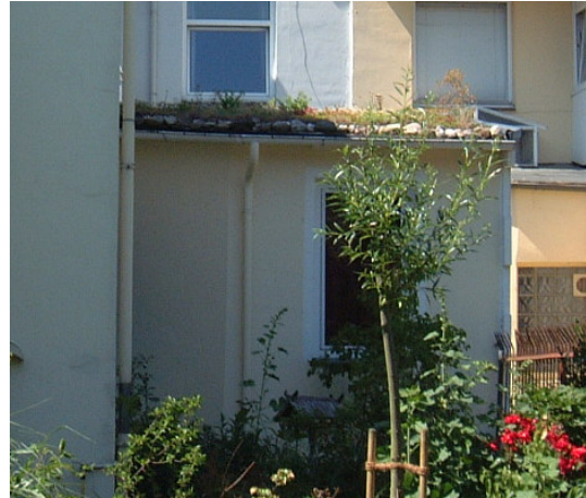
Anbau nach der Sanierung
