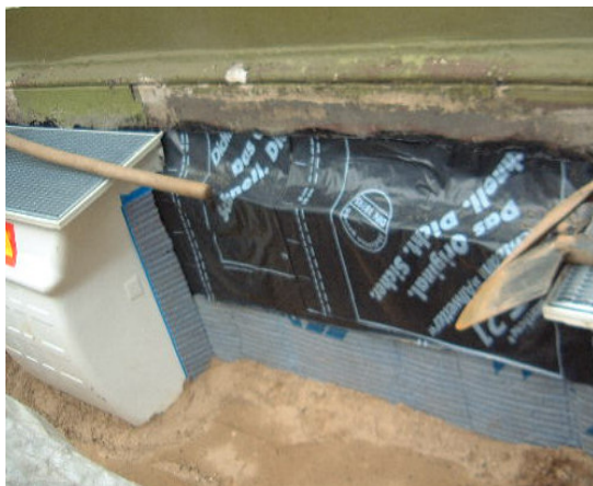
Abdichtung zum Gebäude mit spezieller Dichtungsbahn und später gesetzter Abschluss-Schiene
