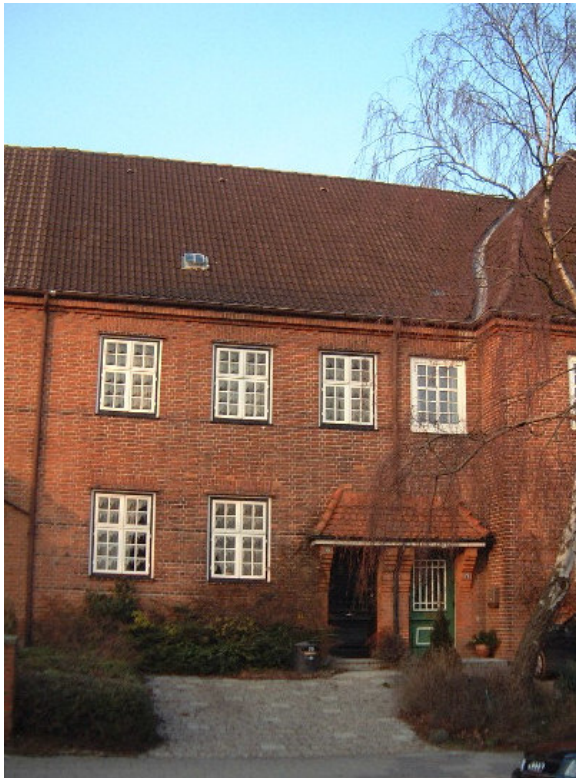
Strassenseite (Süden) vor der Sanierung
