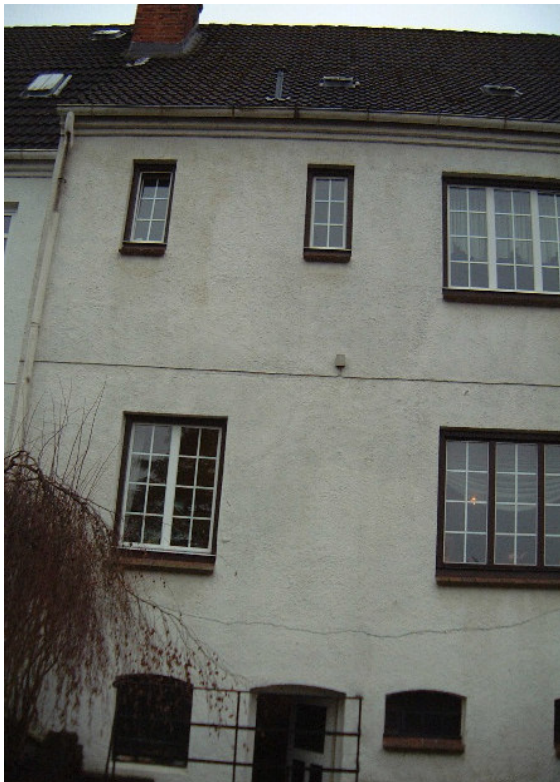
Gartenseite (Norden) vor der Sanierung
