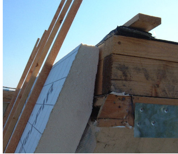
Übergang Steildach / Flachdach
