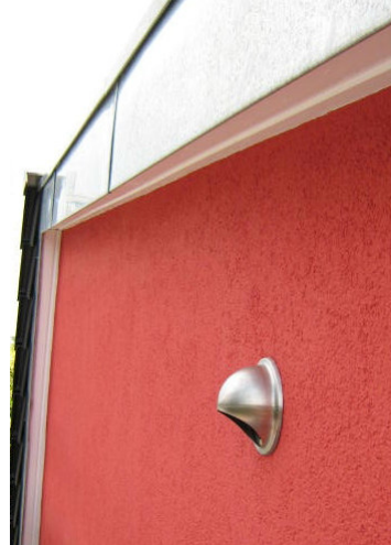
Wandausblasstutzen Lüftungsanlage
