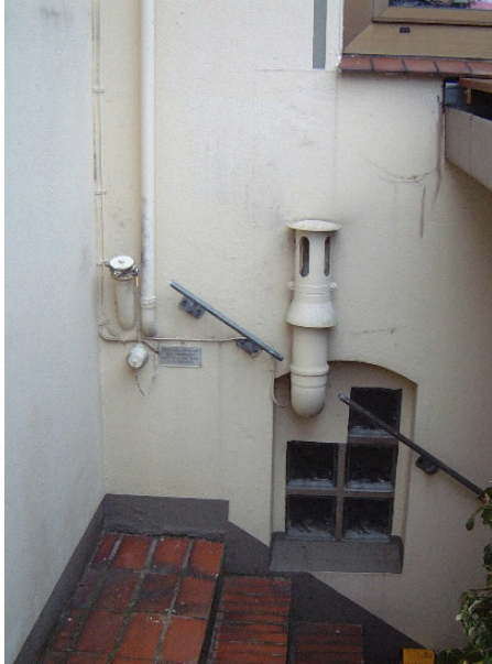
Öleinfüllstutzen vor Verlegung
