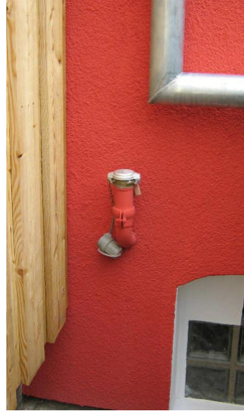
nach Abschluß der Arbeiten
