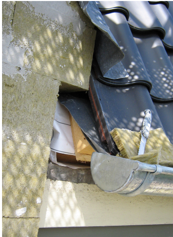
während der Arbeiten
