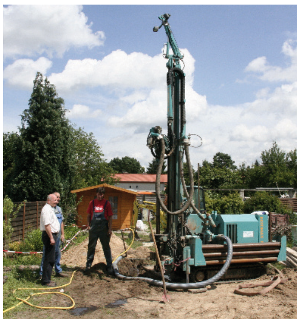
Bohrung für die Sonden der Erdwärmepumpe
