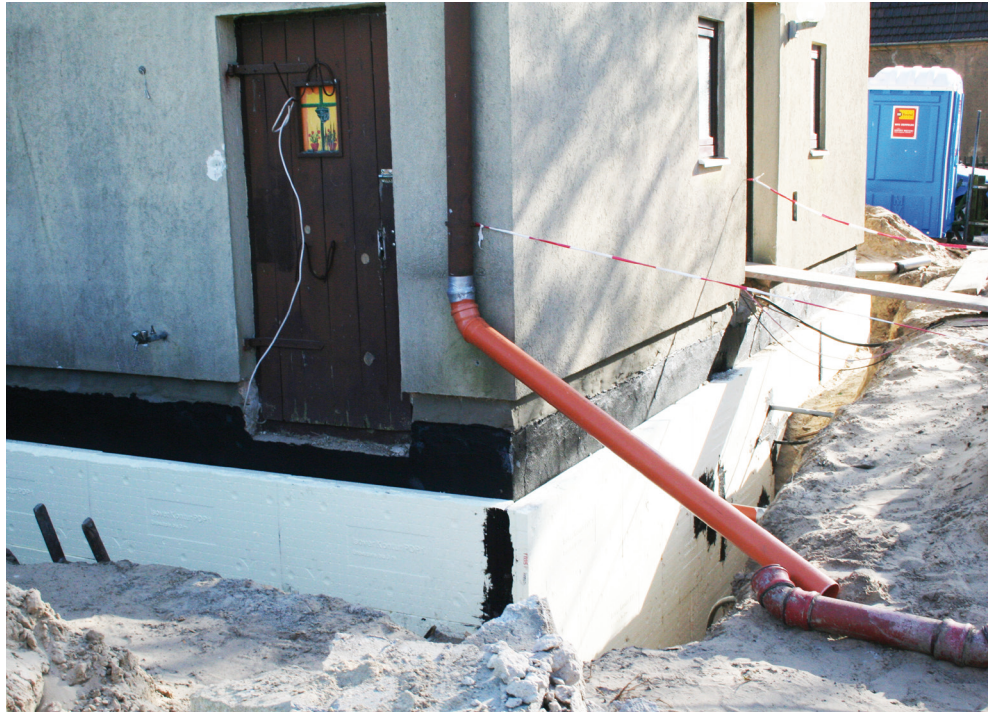
Bauwerkstrockenlegung und Perimeterdämmung
