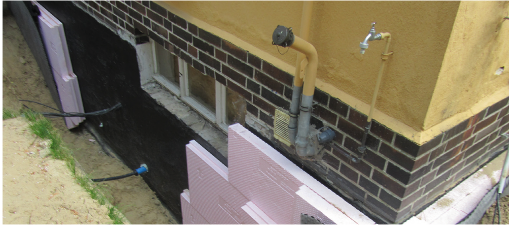
Aussenwandabdichtung / Vertikal - Abdichtung
