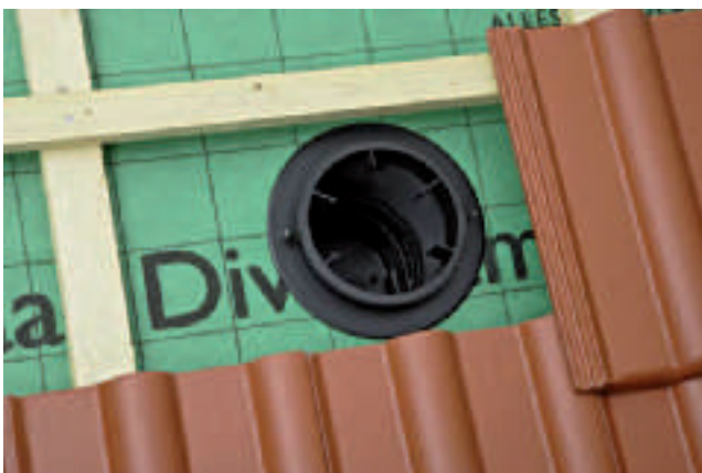
Foto 1 DivoDämm Anschlusshülse eingebaut
