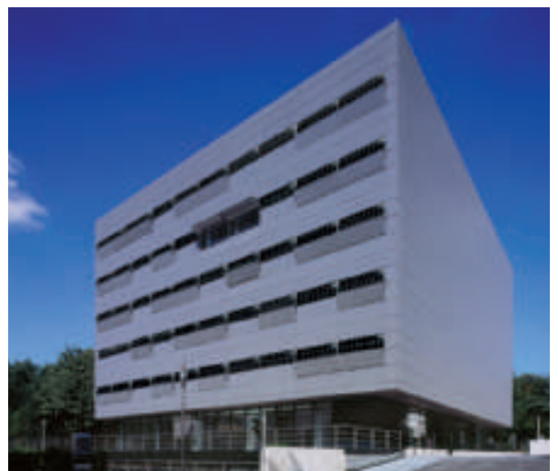
Darstellung Horizontaler Fallladen mit Photovoltaikzellen (Fotomontage)
