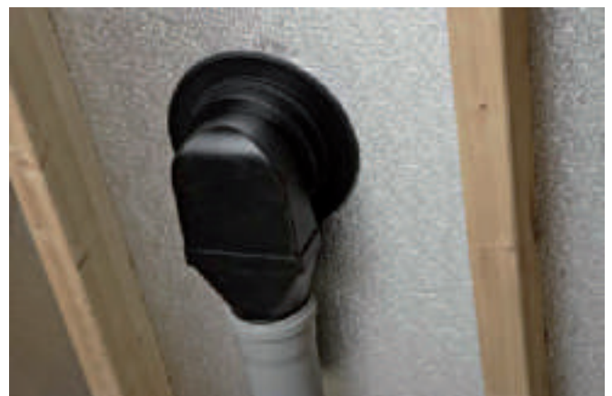
Foto 2 DivoDämm Anschlusshülse - unterer Anschluss -
