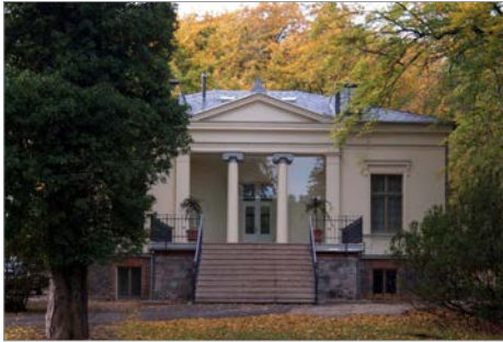
Villa Seeblick, Heringsdorf Baudenkmal 1876 von 45 l(m 2 /a) auf 6 l(m 2 /a)
