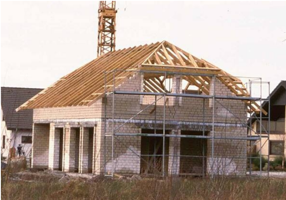
Bild 3: Rohbauzustand eines Massivbaus mit Holzdach - www.sideware.de entnommen
