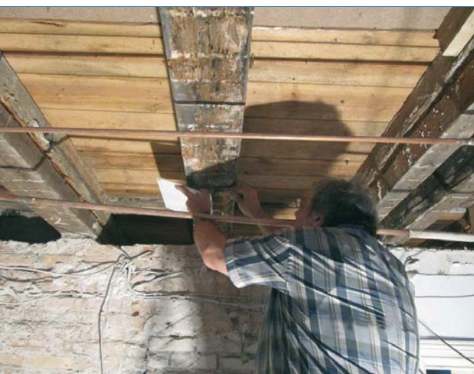
Detaillierte Untersuchung der Kellerdeckenbalken auf Holzschäden
