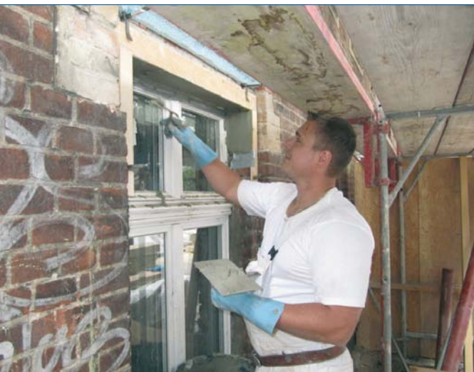
Die Fensterleibung wird ausgebessert.
