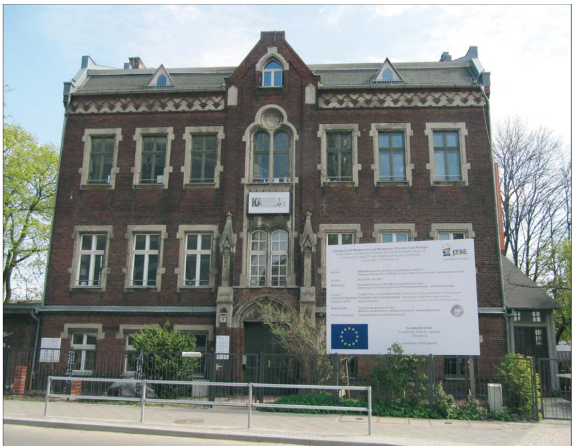
Das denkmalgeschützte Backsteingebäude der Montessorischule wird integrativ umgebaut: Lernende Handwerker und laufender Schulbetrieb.
