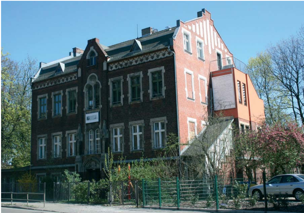
Das denkmalgeschützte Schulgebäude in Berlin Pankow
