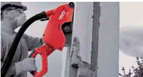
Öffnungen für Fenster bis 240 mm (120 mm Schnitt von beiden Seiten)
