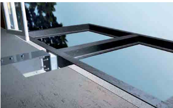
Thermische Trennung zwischen Stahlbalkon und Stahlbetondecke
