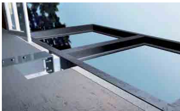
Thermische Trennung zwischen Stahlbalkon und Stahlbetondecke
