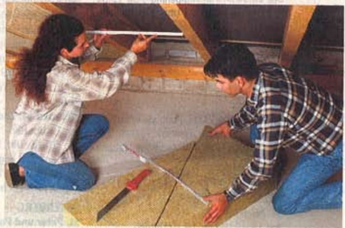
Vor Beginn der Dämmarbeiten sollten sich Bauherren ein Konzept von einem Fachmann erstellen lassen.
