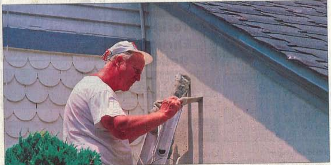
Eine optische und energetische Sanierung der Hausfassade steigert den Wert der Immobilie. Foto: nh
