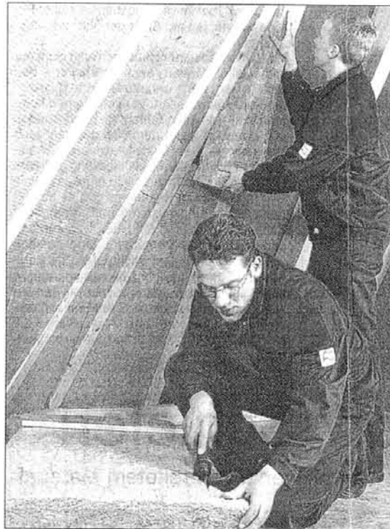
Hauptsache leicht zu verarbeiten: Mineralfasern oder Hanf (kleines Bild) lassen sich als minimal größer geschnittene Keile zwischen die Sparren klemmen. Fotos: Innung / tnn
