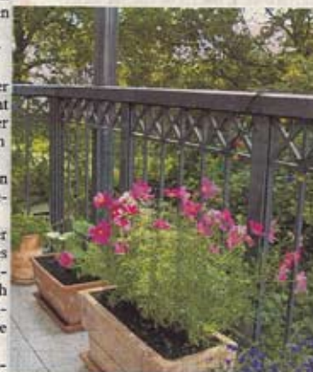
Die Harmonie trägt: Viele Balkone haben kleine Bauschäden, die häufig nicht entdeckt werden.
