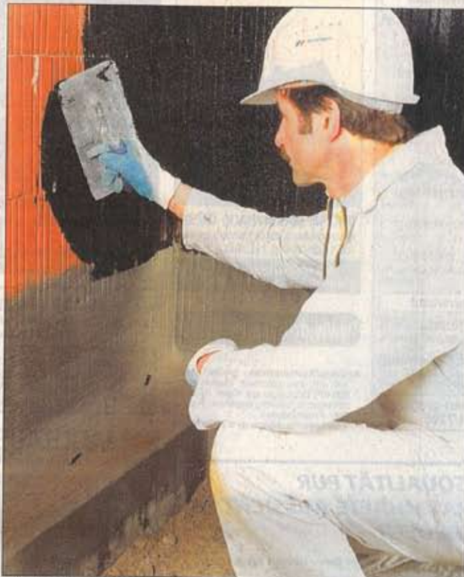
Schnell und umsichtig handeln: Ein feuchter Keller sollte abgedichtet werden, sonst drohen Schäden und dann sinkt der Wert des Hauses.
