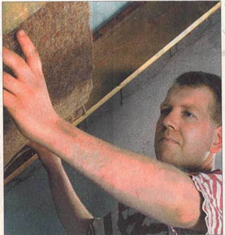
Ökologische Dämmstoffe wie Hanf lassen sich zwischen oder unter den Sparren anbringen. FOTO: TMN
