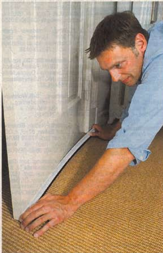
Mit einer sogenannten Bürstendichtung lässt sich der Spalt zwischen Tür und Boden schnell und einfach schließen. FOTO: OPA
