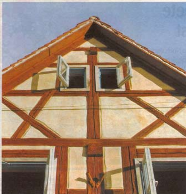
Die unebene Oberfläche zwischen den Fachwerkhältern zeigt: Hier wurde Lehm zum Ausfachen und Verputzen verwendet. Immer häufiger erobert der gesunde Baustoff jetzt Innenräume
