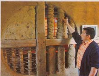
Verschiedene Techniken kennt der Lehmbau. Das Material braucht an der Außenwand allerdings einen Feuchtigkeitsschutz und wegen der Energieeinsparverordnung eine zusätzliche Wärmedämmung
