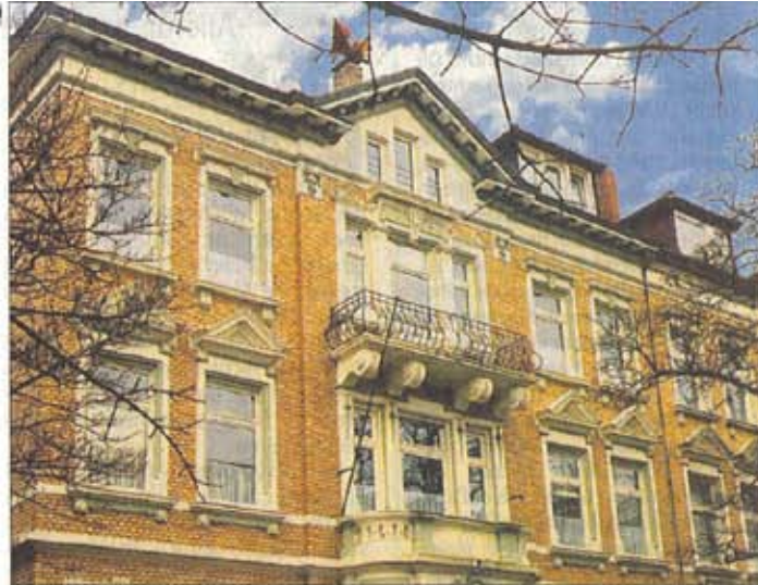
Erhaltenswerte Fassade: Hier empfiehlt sich eine Innendämmung.
