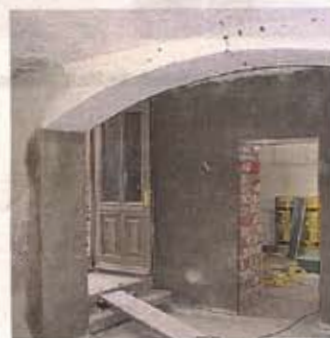
Vorher/Nachher: Der Ausbau des Kellers ist kostenintensiv, kann sich jedoch lohnen.
