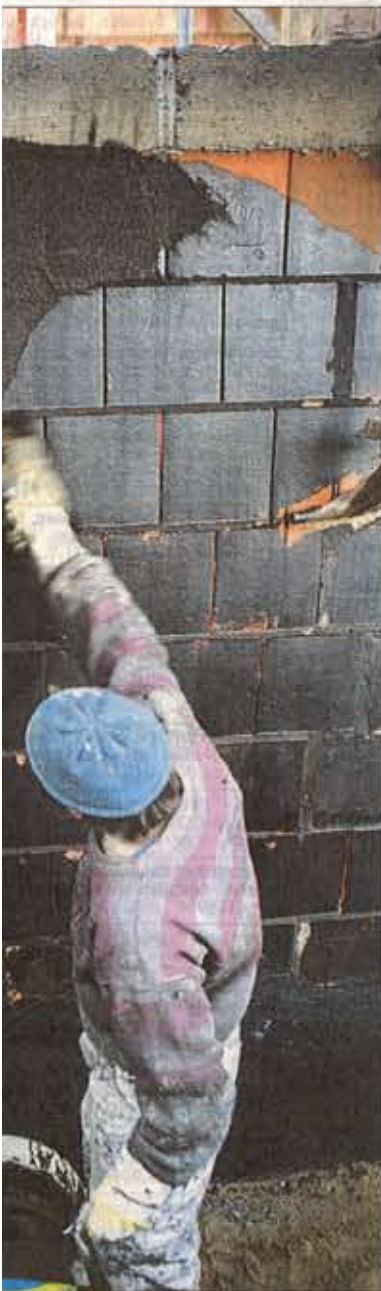
gute Abdichtung der Außenwand. Foto: Jochen Tack
