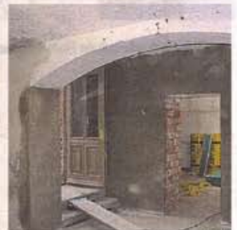
Vorher/Nachher: Der Ausbau des Kellers ist kostenintensiv, kann sich jedoch lohnen.
