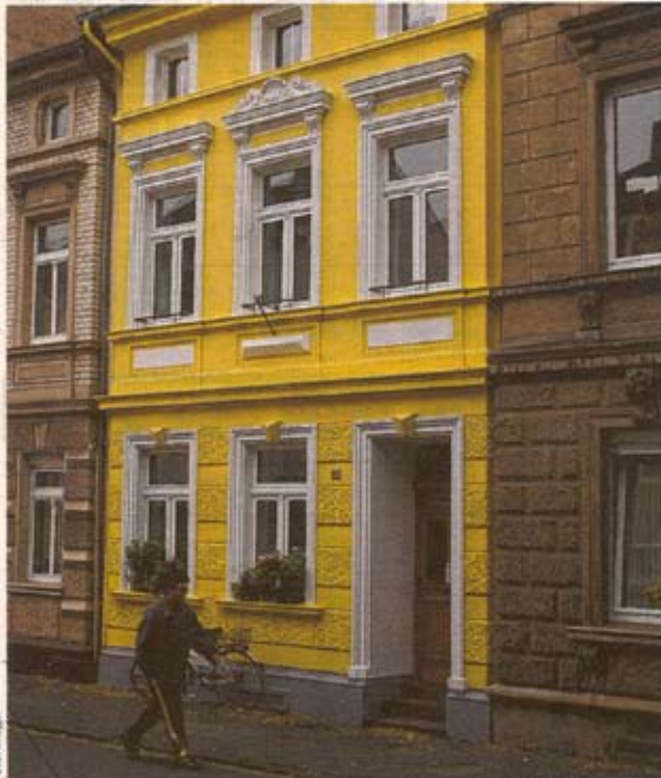
Ein Gründerzeithaus muss keine Energieschleuder sein: Wer es wie hier in Bonn saniert, kann den Heizverbrauch um mehr als die Hälfte senken.
