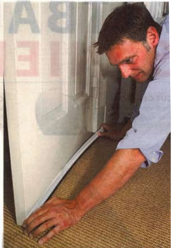
Auch eine Spar-Maßnahme: Mit einer sogenannten Bürstendichtung lässt sich der Spalt zwischen Tür und Boden schnell und einfach schließen. BILD: DPA
