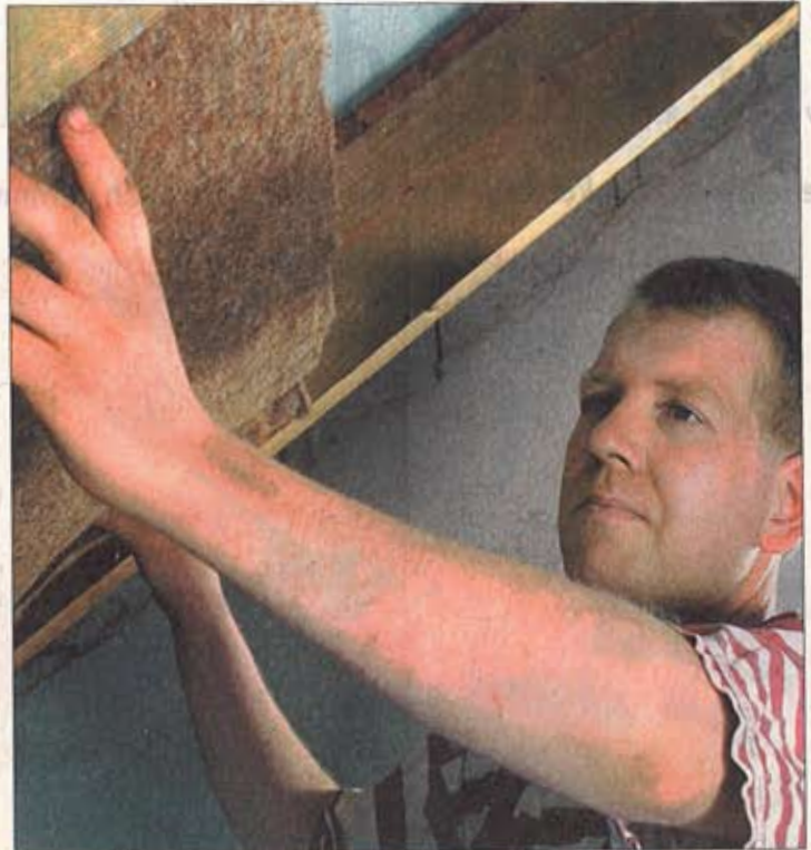
Ökologische Dämmstoffe wie Hanf lassen sich zwischen oder unter den Sparren anbringen.
