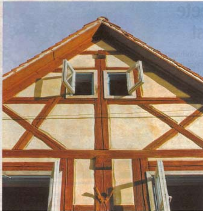
Die unebene Oberfläche zwischen den Fachwerkhölzern zeigt: Hier wurde Lehm zum Ausfachen und Verputzen verwendet. Immer häufiger erobert der gesunde Baustoff jetzt Innenräume
