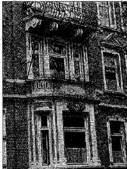
Die Fassaden von Altbauten sind besonders anfällig für Frostschäden. FOTO: DPA
