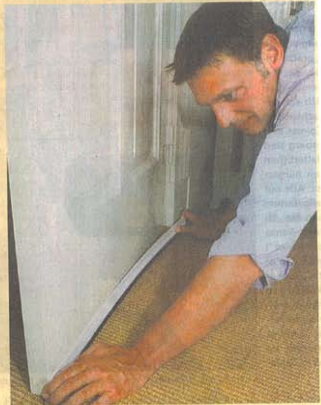
Auch eine Spar-Maßnahme: Mit einer sogenannten Bürstendichtung lässt sich der Spalt zwischen Tür und Boden schnell und einfach schließen.
