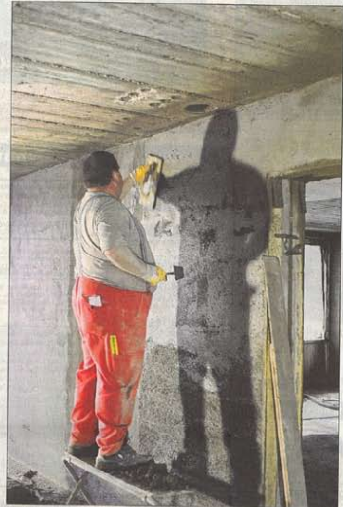
Kleinere Risse in der Wand lassen sich bei der nächsten Renovierung beseitigen. Breitet sich ein Riss aber aus, sollte rechtzeitig ein Fachmann hinzugezogen werden. Bild: Jens Schierenbeck/dpa/tmn
