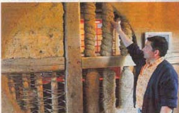
So kann eine Lehmwand aufgebaut sein: Außenwände brauchen eine zusätzliche Wärmedämmung. Foto: dpa
