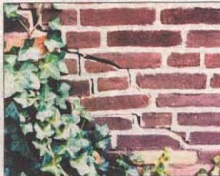
DURCH AUSTROCKNUNG des Bodens entstehen Risse in Mauern, durch die Feuchtigkeit eindringt. Foto: gms
