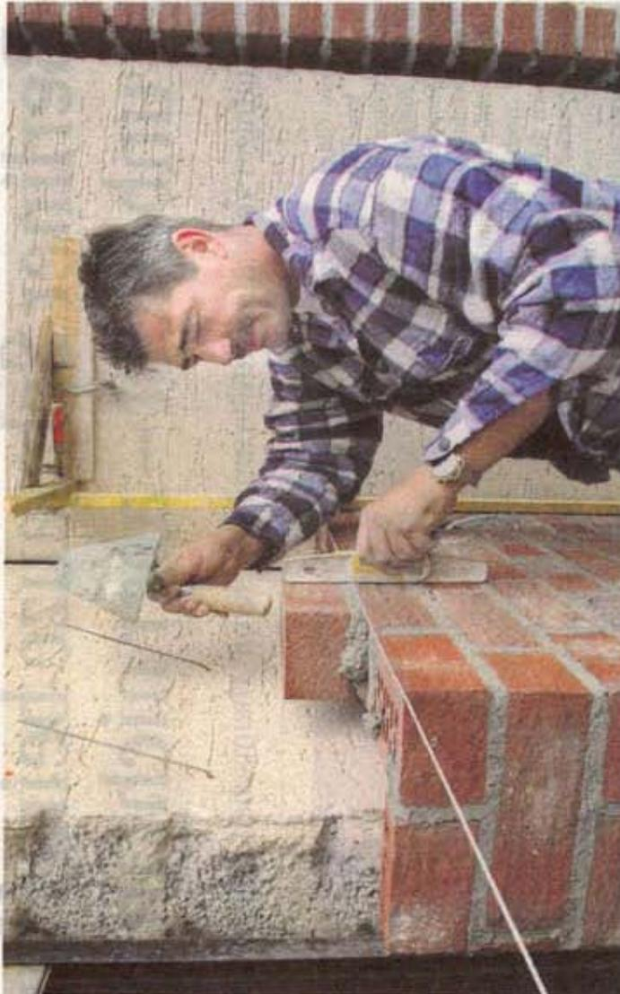
Auch eine Dämmung: Mit einer zusätzlichen Klinkerstein-Schicht erhöht sich die Qualität der Außenwand
