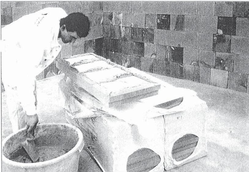
**Dämmplatte aus Resol-Hartschaum:** Der Klebemörtel wird rahmenförmig mit drei senkrechten Stegen auf die Dämmplatte aufgebracht.
