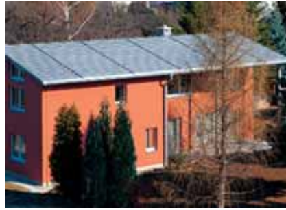
Das weltweit erste vollständig mit QUICK STEP®-SolarThermie beheizte Wohnhaus
