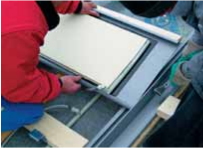
Montage der steckfertig verrohrten QUICK STEP®-Solar-Paneele
