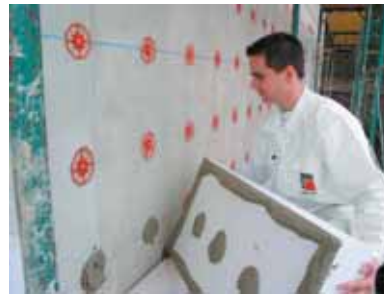
Verklebung der Dämmplatten in der Rand-Wulst-Punkt-Methode.
