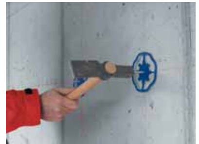
Anbringen des KlebeAnkers Beton.
