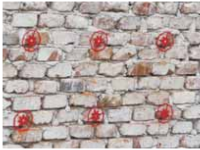
KlebeAnker auf schadhaftem Mauerwerk im Raster versetzt (40 x 40 cm).
