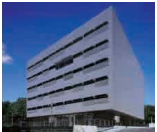
Darstellung Horizontaler Fallladen mit Photovoltaikzellen (Fotomontage)
