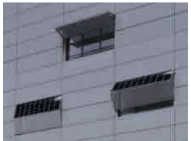
Hier ist die Anbringung der Photovoltaikzellen und die Nachfahrmöglichkeit zur Optimierung der Sonneneinstrahlung (Wirkungsgrad) gut zu erkennen.
