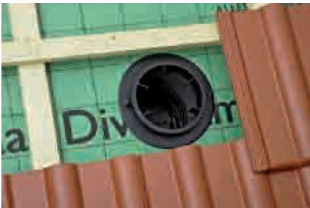
Foto 1 DivoDämm Anschlusshülse eingebaut
