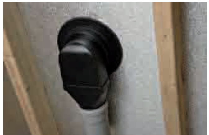
Foto 2 DivoDämm Anschlusshülse - unterer Anschluss -
